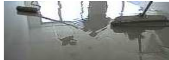
Auftragen von Spachtelmasse mit Rakel, Entlüften mit Stachelwalze
