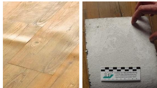
PVC (LVT Designbelag) auf nicht belegreifem Calciumsulfatestrich. Typisch ist die Blasenbildung und die am Belag bzw. der Spachtelmasse anhaftende „Estrichoberfläche“
