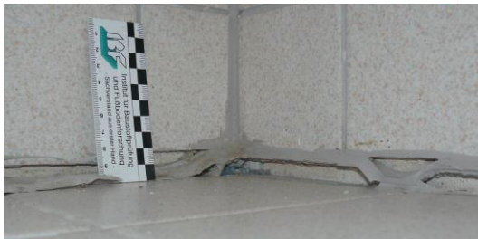
Absenkung einer Raumecke durch Verformung des Zementestrichs
